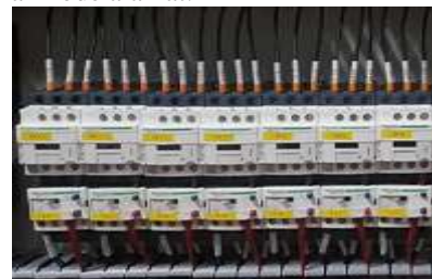
Gambar 9. Pemberian Alamat Pada Komponen dan Kabel
