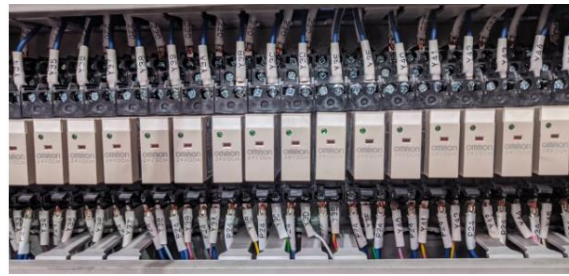
Gambar 19. Pemberian Alamat Pada Komponen dan Kabel
