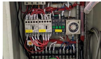
Gambar 22. Pemberian Label Pada Komponen dan Kabel
