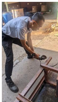
Gambar 24 Pemotongan Dengan Gerinda Tangan
