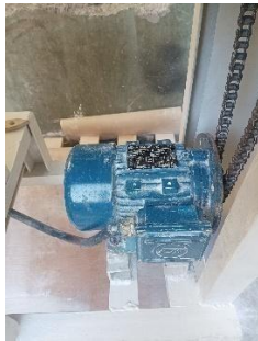
Gambar 28. Pemasangan Motor AC 3 Phase
