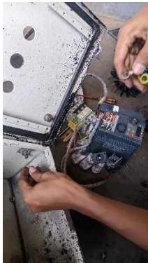
Gambar 29. Pemasangan Inverter dan Part – Partnya
