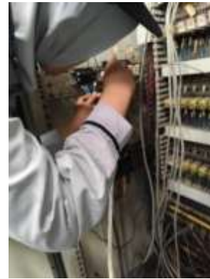
Gambar 23. Proses Instalasi dan Penarikan Kabel
