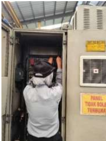
Gambar 21. Proses Pemasangan Komponen
